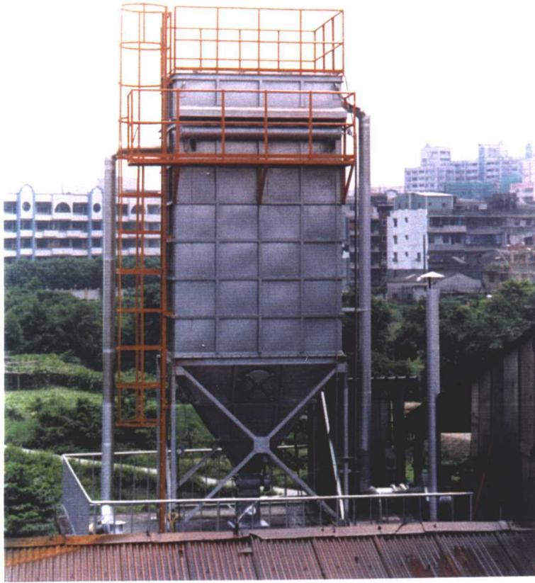
圖 4.1 工廠廢氣處理系統使用的袋式集塵器
